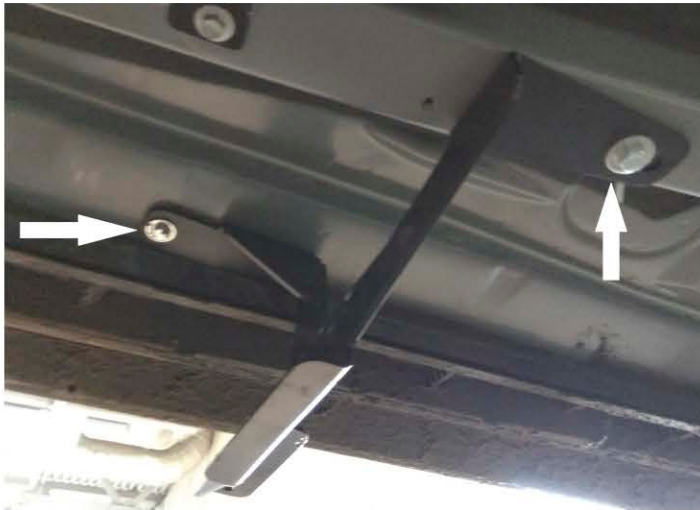
Рис. 5 - Установка среднего кронштейна
