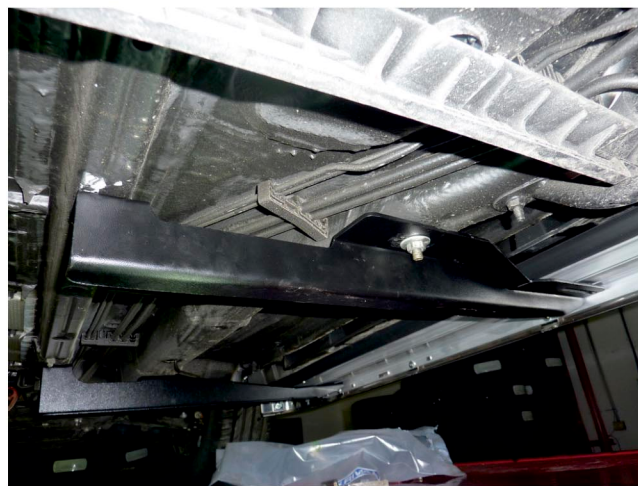
Рис. 4 - Установка среднего кронштейна
